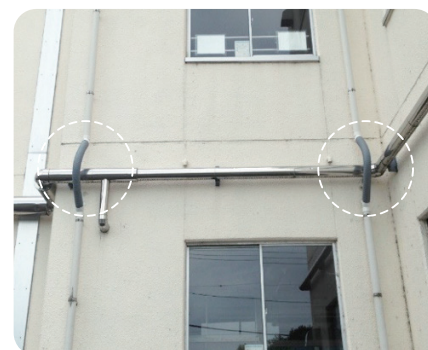
埼玉県 小学校 雨水管修繕 [2015年施工]
