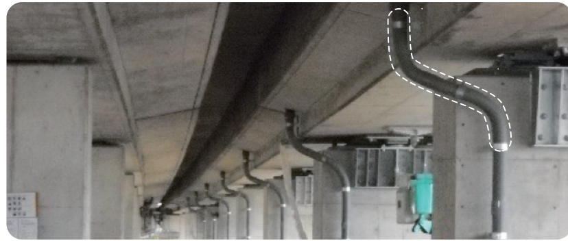
兵庫県 高速道路 耐震補強工事 [2015年施工]
