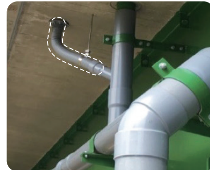
大阪府 橋梁 補修補強工事 [2016年施工]
