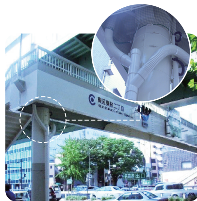
愛知県 歩道橋 補修工事 [2010年施工]
