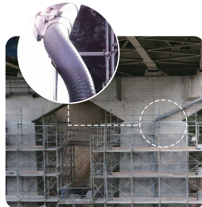
奈良県 国道 耐震補強工事 [2011年施工]
