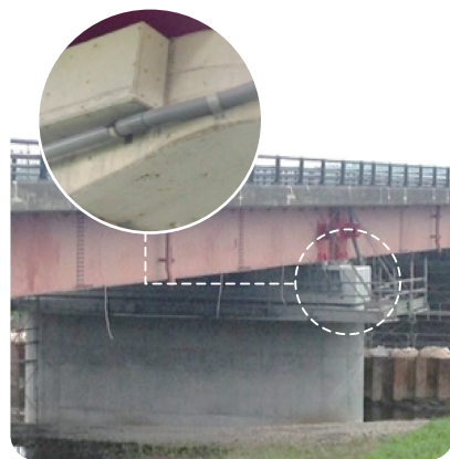
宮城県 橋梁 耐震化事業 [2013年施工]
