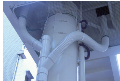
歩道橋排水配管
