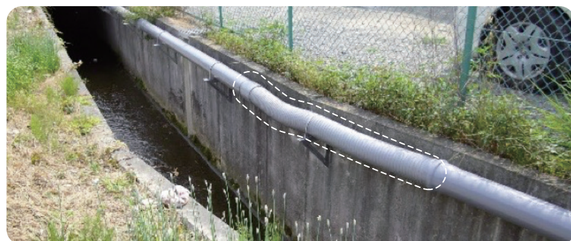
岩手県 仮設住宅 汚水排水管路 [2011年施工]
