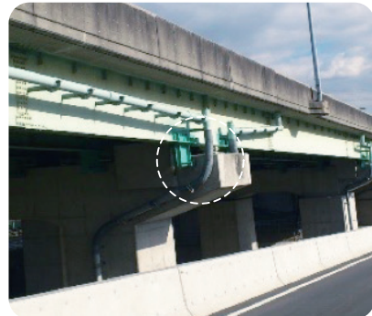
愛知県 国道 補強補修工事 [2014年施工]
